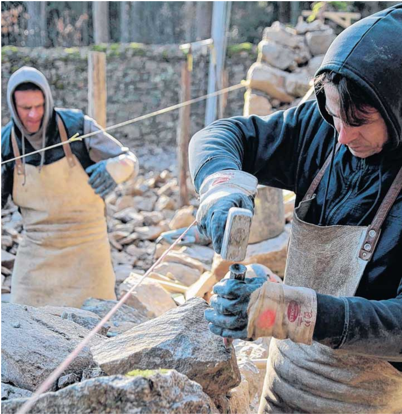
Benjamin Kühne (r.) und Marius Neuber verbauen 30 Steine pro Tag für die neue alte Mauer am Saugarten. Die reichlich 17 Meter lange und zweieinhalb Meter hohe Natursteinmauer rechts vom Eingang drohte einzustürzen. Foto: Bernd Lichtenberger
